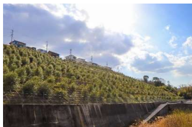
町有地である法面
