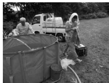
組立てた防火水槽に 運搬した水を入れる作業
