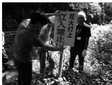
立入禁止看板の設置作業
