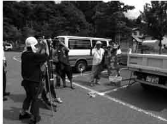
のほりを立てる作業
