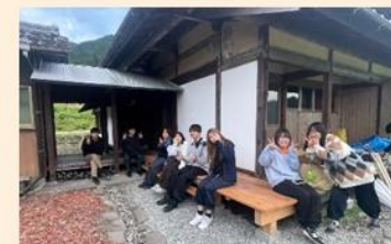
空き家の改修
